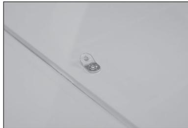
88. Faites glisser une deuxième languette sur la vis depuis le bas du stabilisateur. Fixez les languettes à l'aide d'un écrou M3. Utilisez du frein-filet sur toutes les fixations métal-métal.
