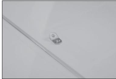
**165.** Faites glisser une deuxième languette sur la vis depuis le bas du stabilisateur. Fixez les languettes à l'aide d'un contre-écrou M3.
